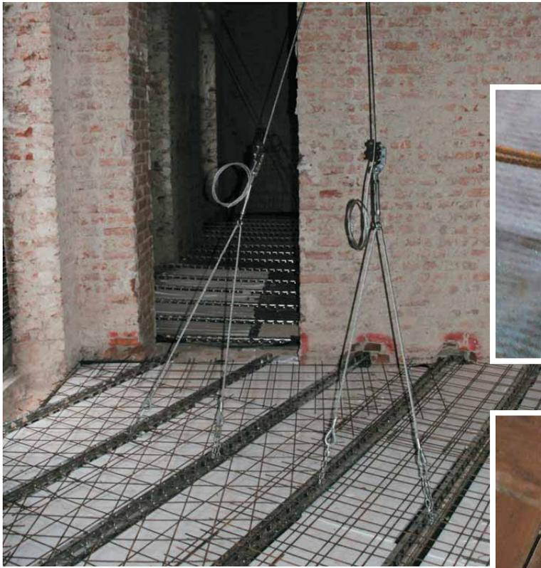
Solaio rinforzato con pannelli di isolante interposti fra i tralicci, rete elettrosaldata prima del getto in CLS
