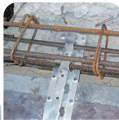
Particolare del nodo armatura del cordolo con Traliccio LPR®
