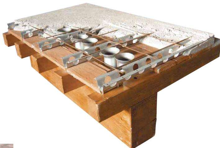
Preparazione del solaio per l'inserimento dei connettore FLAP® sulla trave primaria con asportazione delle pianelle in prossimità della trave rompitratta
