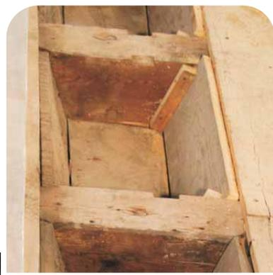
Particolare di una trave rompitratta preparata con metope "spondine" di legno per il contenimento del CLS
