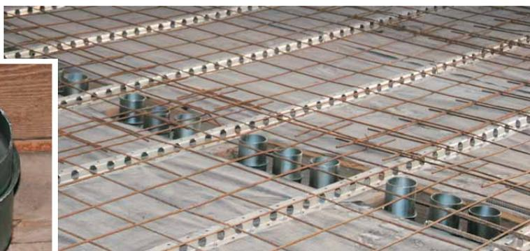
Solaio visto dall'estradosso già rinforzato con Connettore FLAP® e Traliccio LPR®, rete appoggiata direttamente sul traliccio senza distanziatori
