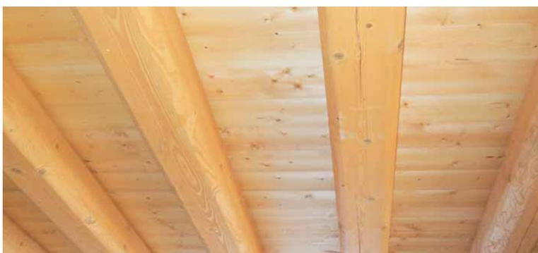
Solaio nuovo di legno massiccio con travi uso fiume visto dall'intradosso
