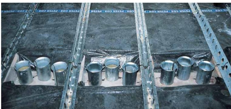
Traliccio LPR® e Connettore FLAP® posati sul tavolato e sulle travi
