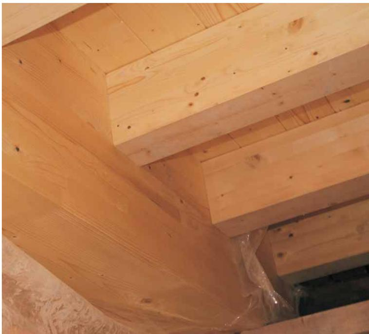
Solaio nuovo con travetti complanari alla trave visto dall'intradosso
