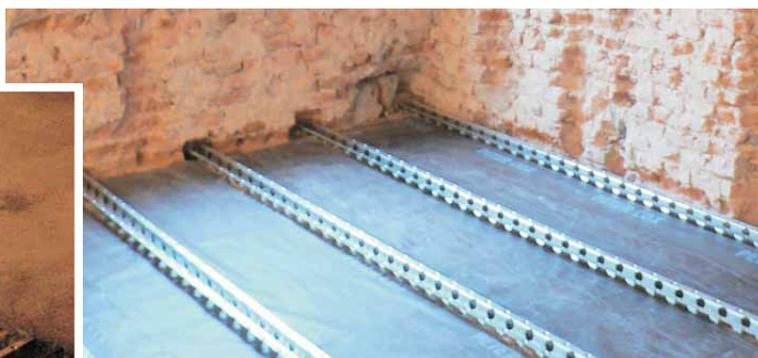
Vecchio solaio con travi uso fiume e Traliccio LPR® rovescio inserito all'interno della muratura
