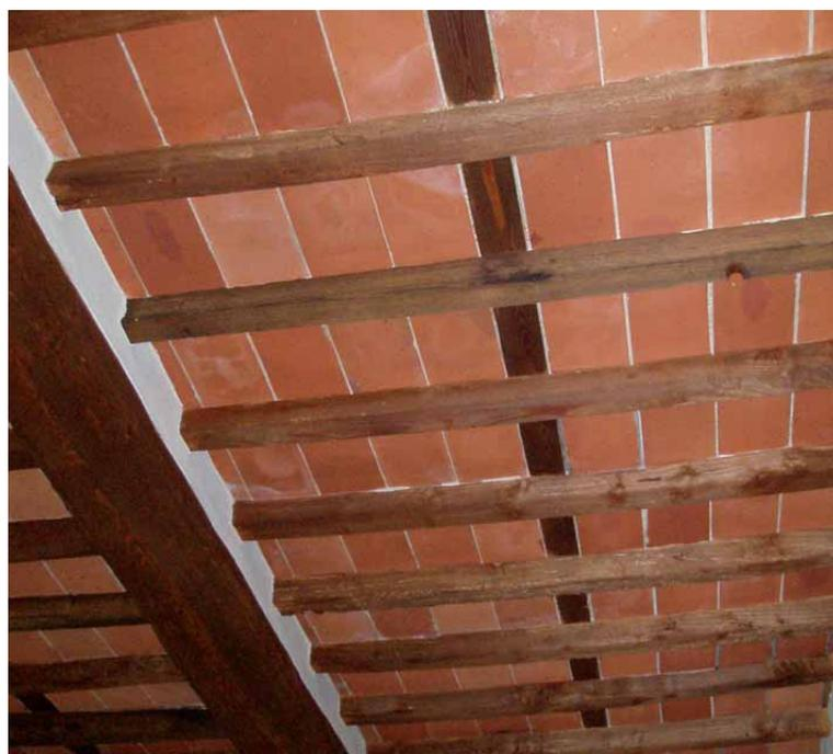
Solaio visto all'intradosso con intonaco di finitura fra i travetti dell'ordinatura secondaria
