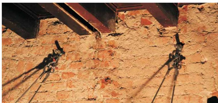
Particolare dell'aggancio su muratura portante con barre resinare e tiranti che sostengono il solaio in fase di getto del CLS
