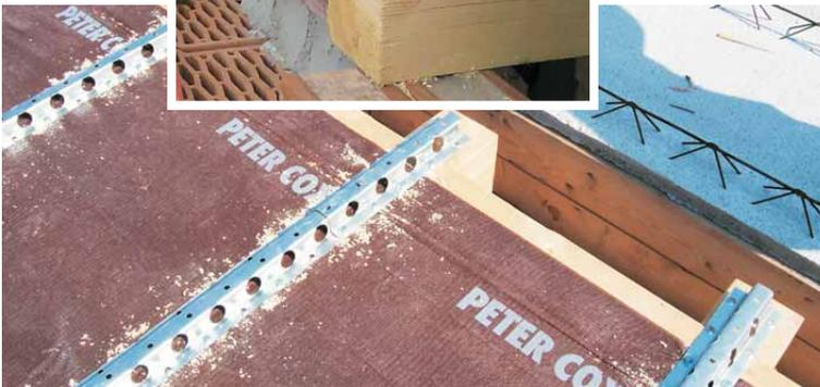
Nuovo solaio di legno con travi e Traliccio LPR® inseriti nel cordolo prima del getto in CLS
