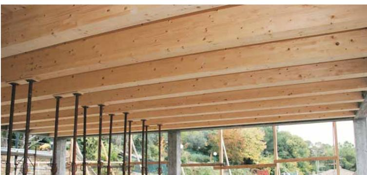
Solaio visto dall'intradosso con particolare della puntellazione eseguita prima del getto in CLS
