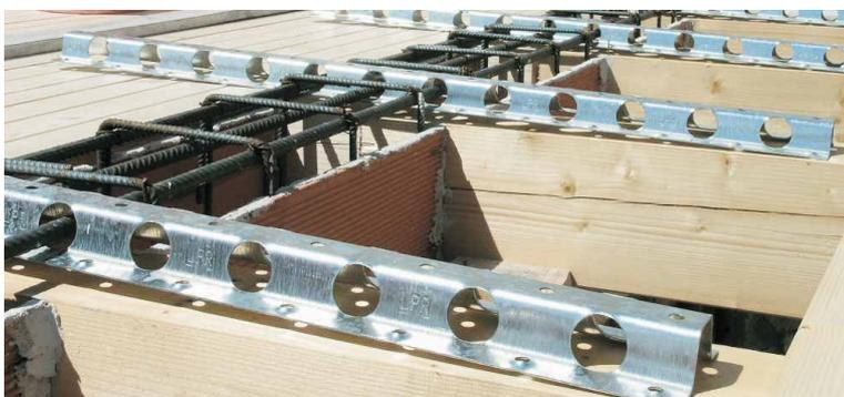
Spezzoni di Traliccio LPR® da inserire in fase di costruzione del cordolo
