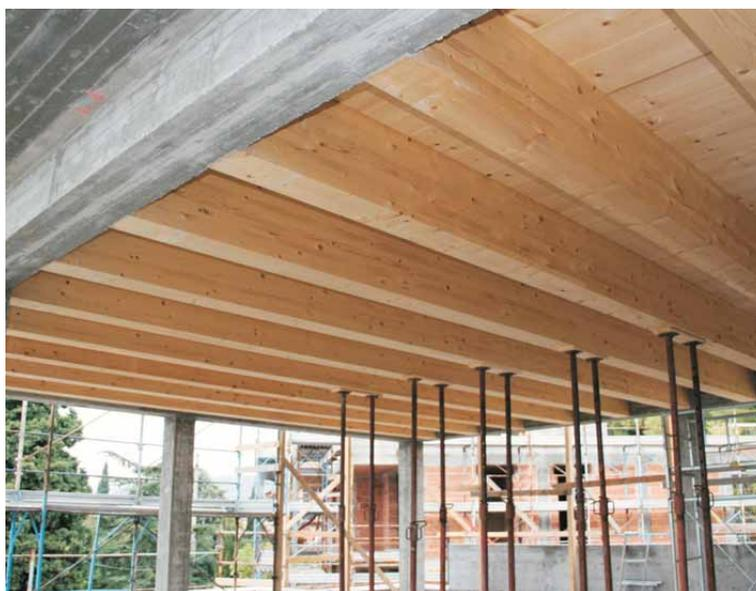
Vista del solaio di legno lamellare all'intradosso
