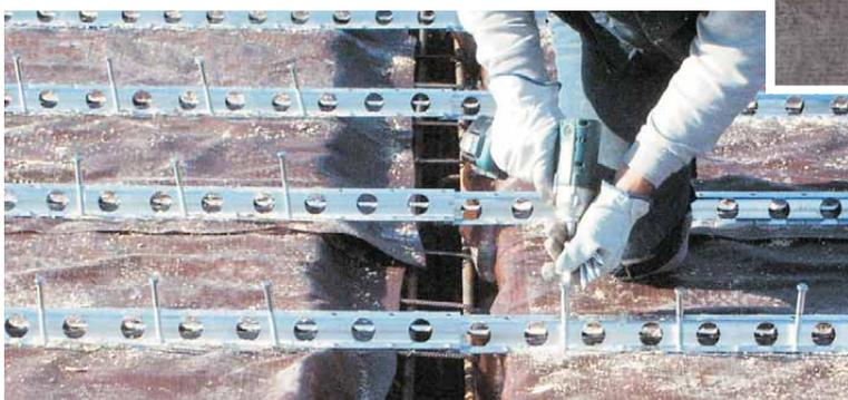
Fase di esecuzione della posa del Traliccio LPR® continuo tra i due solai del piano
