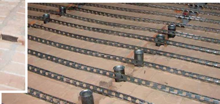
Solaio visto dall'estradosso con Connettore FLAP® e Traliccio LPR® già posizionati, pronto per la posa della rete e del getto in cls
