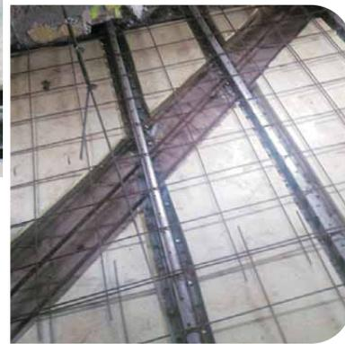
Correa d'irrigidimento d'angolo solaio per effetto piastra
