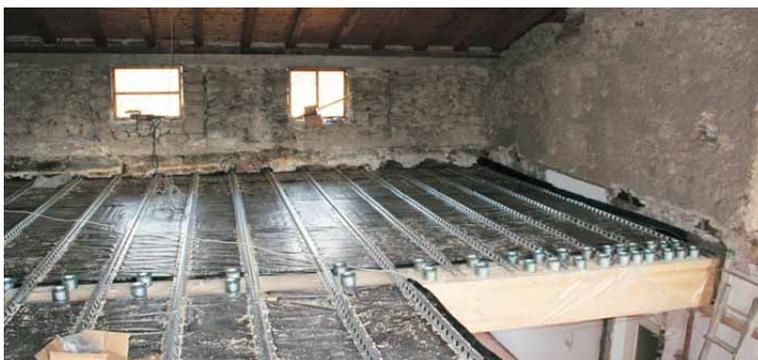
Solaio rinforzato con Connettore FLAP<sup>®</sup> ribassati specificatamente per le travi complanari e Traliccio LPR<sup>®</sup> continuo sulla trave
